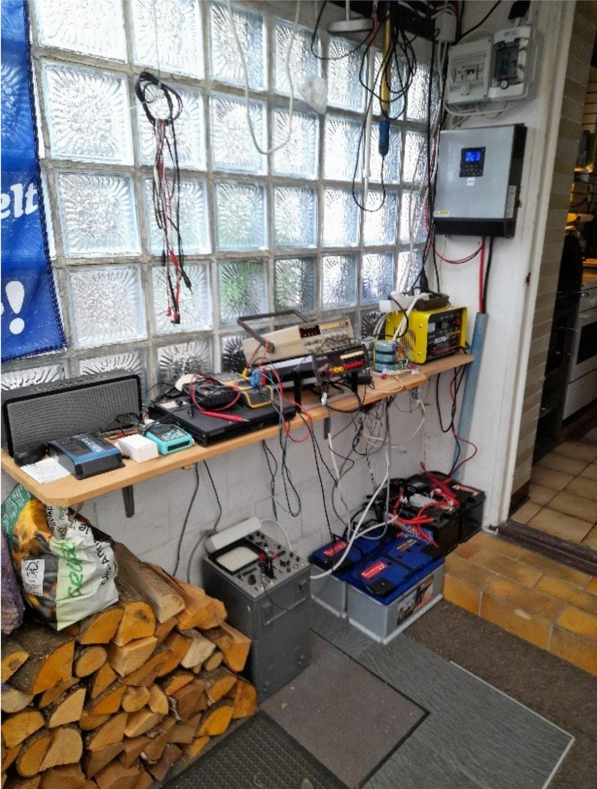
**Abb. 13:** Die "Werkstatt" auf dem Regalbrett. Im Hintergrund die USV an der Wand und darunter die Akkuanlage mit insgesamt 440 Ah, die 200 Ah der meistens angekoppelten mobilen Stromversorgung nicht mit gerechnet.
