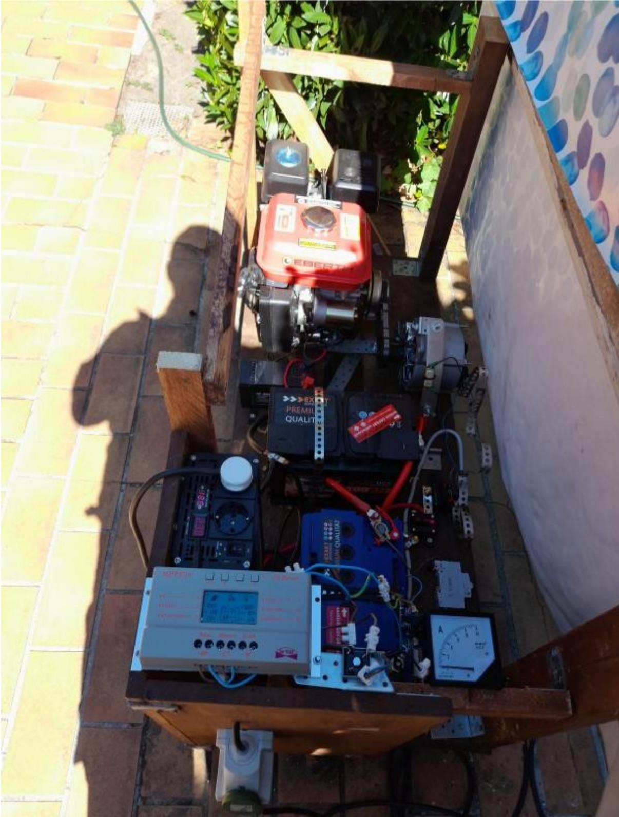
**Abb. 11:** Die "Power Station" im Testbetrieb. Die Einspeisung der mobilen PV-Panels und der vertikalen Windturbine erfolgt über die grüne CEE-Steckverbindung. Darüber ist der 12V-MPPT-Laderegler zu sehen. [Schaltplan \(Garten-USV und mobile Stromversorgung\)](#). Hinten der nagelneue 6-PS-China-Motor, der einen ähnlichen Terror verbreitet wie der Endress-Generator mit Briggs&Stratton-Motor.
