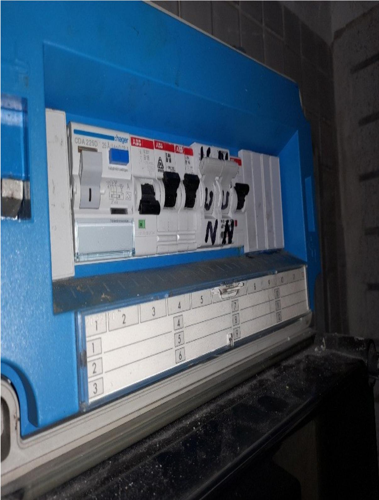
**Abb. 5a:** Links RCD1, daneben die Sicherungen der 3 Stromkreise, dann der 2-pol. Umschalter Netz/USV, daneben die erste Sicherung nach dem Zähler.
