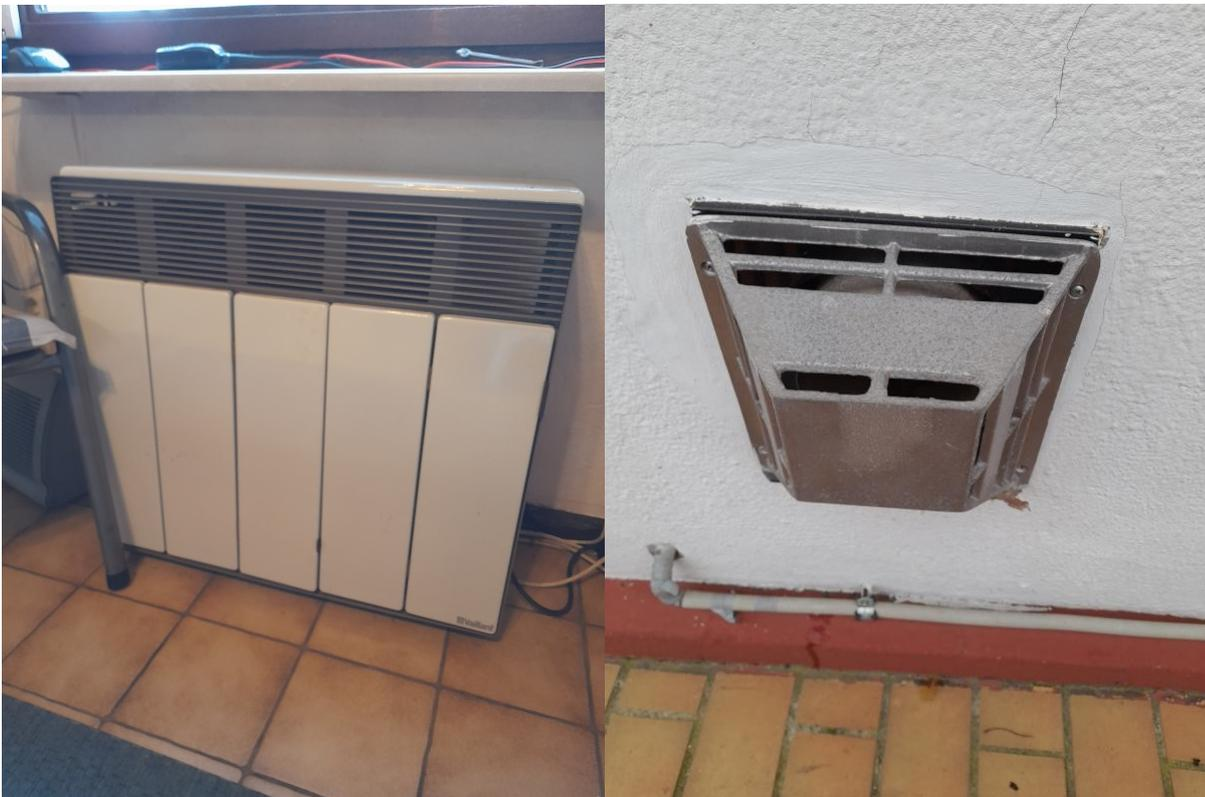
**Abb. 1 und 2:** Gasheizung mit Außenwandanschluss
