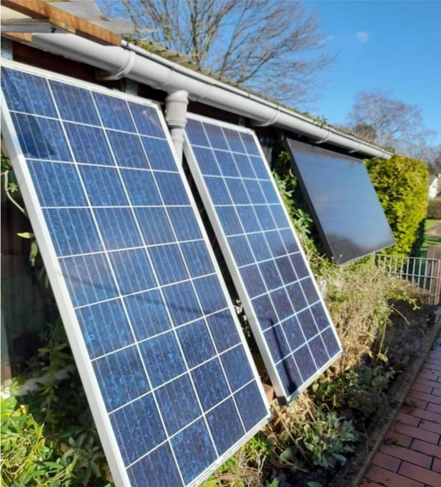
**Abb. 7:** Im Vordergrund zwei Solarpanels für die USV mit jeweils 120W, im Hintergrund das monokristalline Solarpanel mit 330W für den Mikroinverter.
