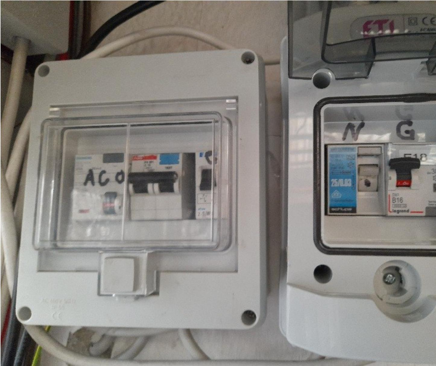
**Abb,5:** Lins der RCD3 hinter der USV, rechts daneben der LS/FI vor der USV (RCD2), dann der Umschalter S2 zwischen Netz und Notstromaggregat. Rechts im Kasten der RCD4 und LS/FI (RCD5) für den Generator.
